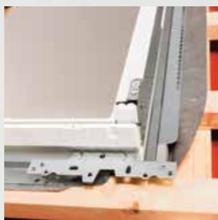
Теплоізоляційний контур надійно утеплює периметр вікна
